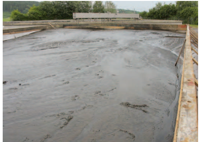
Abb. 8: Befülltes Sandablagerungsbecken am Ende der Arbeiten
