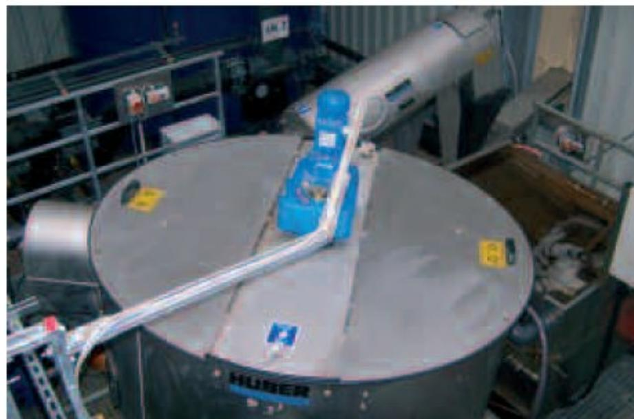
Abb. 2: HUBER ROTAMAT® Scheibeneindicker RoS 2S und HUBER ROTAMAT® Schneckenpresse RoS 3Q
